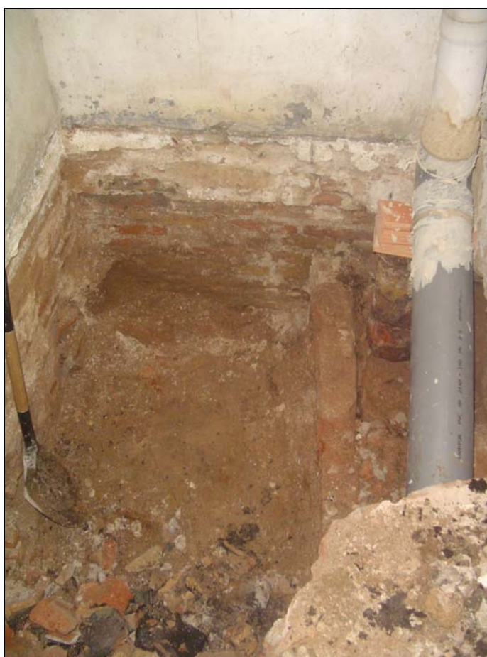
Fotografia 3: Durant els treballs constructius del fossat de l'ascensor.
